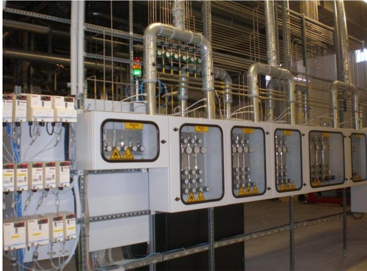
**Figura 2.13:** Sistema de tuberías necesarias para la gestión de gases en el PECVD.
